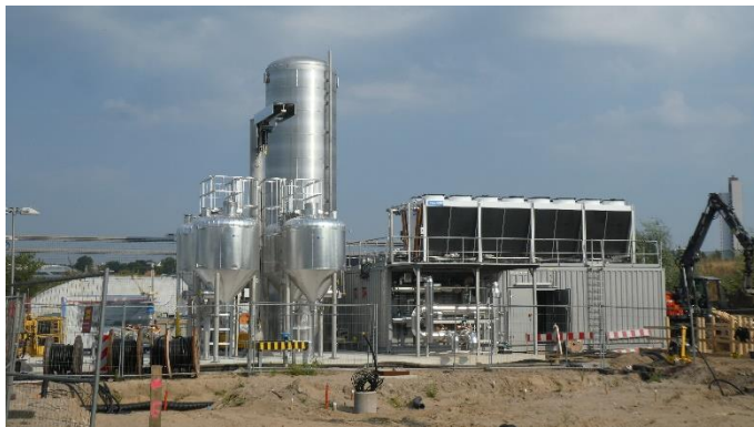
Inbetriebnahme 2020 (600 – 1.500 Nm 3 /h)
