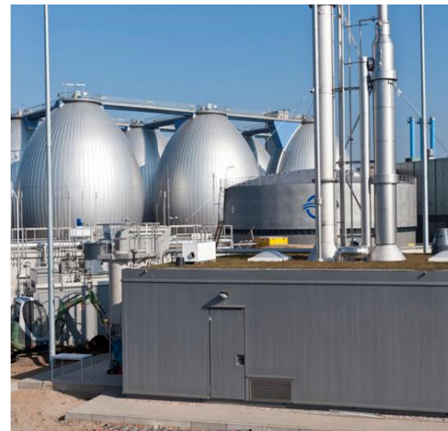
Inbetriebnahme 2011 (550 Nm 3 /h)
